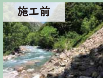
土砂崩れの復旧 (横尾～槍沢)
